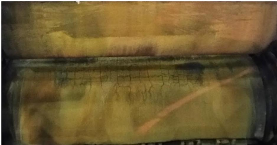
Рисунок 2. Образование трещин в нижнем барабане
