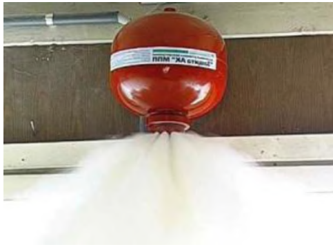
Рисунок 1. Модуль порошкового пожаротушения
