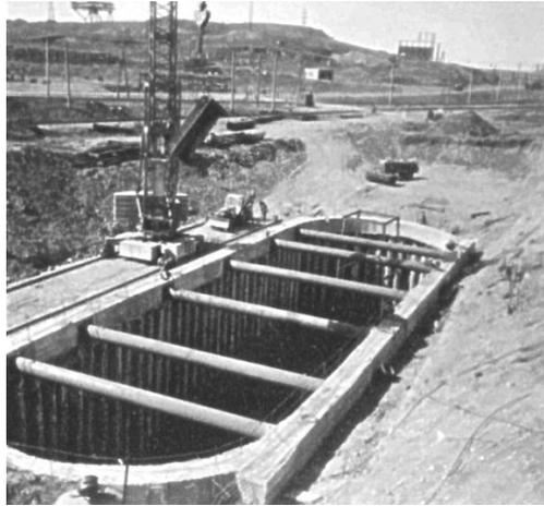
Рисунок 2. Общий вид подземной части вагонопрокидывателя в процессе строительства
