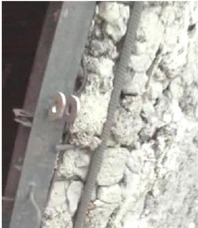
Рисунок 1. Расструктуривание бетона, оголение и коррозия арматуры с юго-западной стороны железобетонного ствола на отм. +197,5м.
