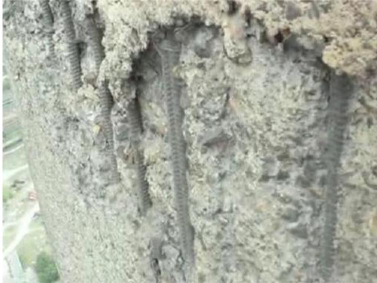
Рисунок 2. Расструктуривание бетона, оголение и коррозия арматуры с юго-западной стороны железобетонного ствола общей площадью до 8,0 м<sup>2</sup> на отм. +219,5 м.
