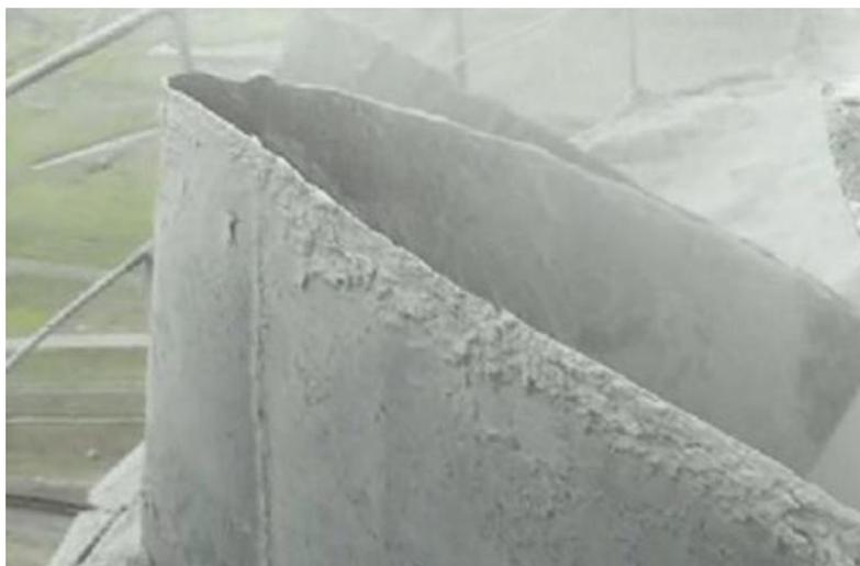
Рисунок 3. Разрушение стального оголовка газоотводящего ствола на отм. +250,0м.
